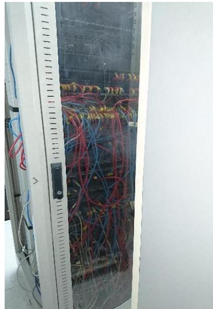
**Desmante de racks y traslado de elementos de comunicaciones a nuevo rack**
